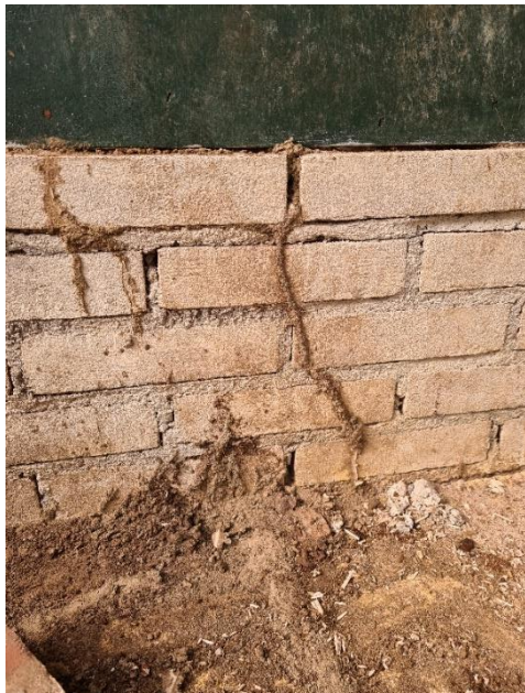
Figuur 3: Een termietentunnel over bakstenen muur, aangelegd door Amerikaanse grondtermieten ( Reticulitermes flavipes ). Bron foto: KAD.
