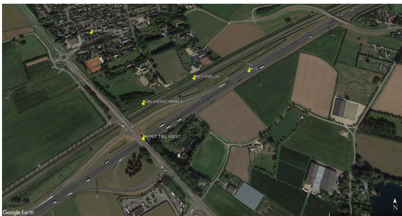
Figuur 2. Ligging geluidsscherm 4 bij afrit Tiel-West aan de noordzijde van de Betuwelijn ten zuiden van Kerk Avezaath.
