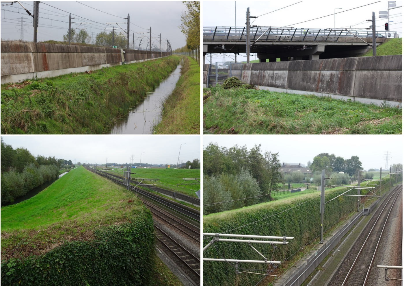
Figuur 11. De geluidsschermen langs de A15 in beheer van Rijkswaterstaat zijn zoals reeds beschreven grotendeels onbegroeid. Dat het echter mogelijk is om een geluidswal in zijn geheel te laten begroeien laat eerder de slangenmuur al zien, maar ook de bovenstaande twee onderste foto's. Dit betreft een gedeelte van de geluidsschermen die geplaatst zijn langs de Betuwelijn ter hoogte van Kerk-Avezaath. Alleen ter hoogte van het dorp is dit uitgevoerd, voor het overgrote deel bestaan ook de geluidsschermen langs de Betuwe op dit deel van het traject uit beton, zoals op de twee bovenste foto's is afgebeeld.
