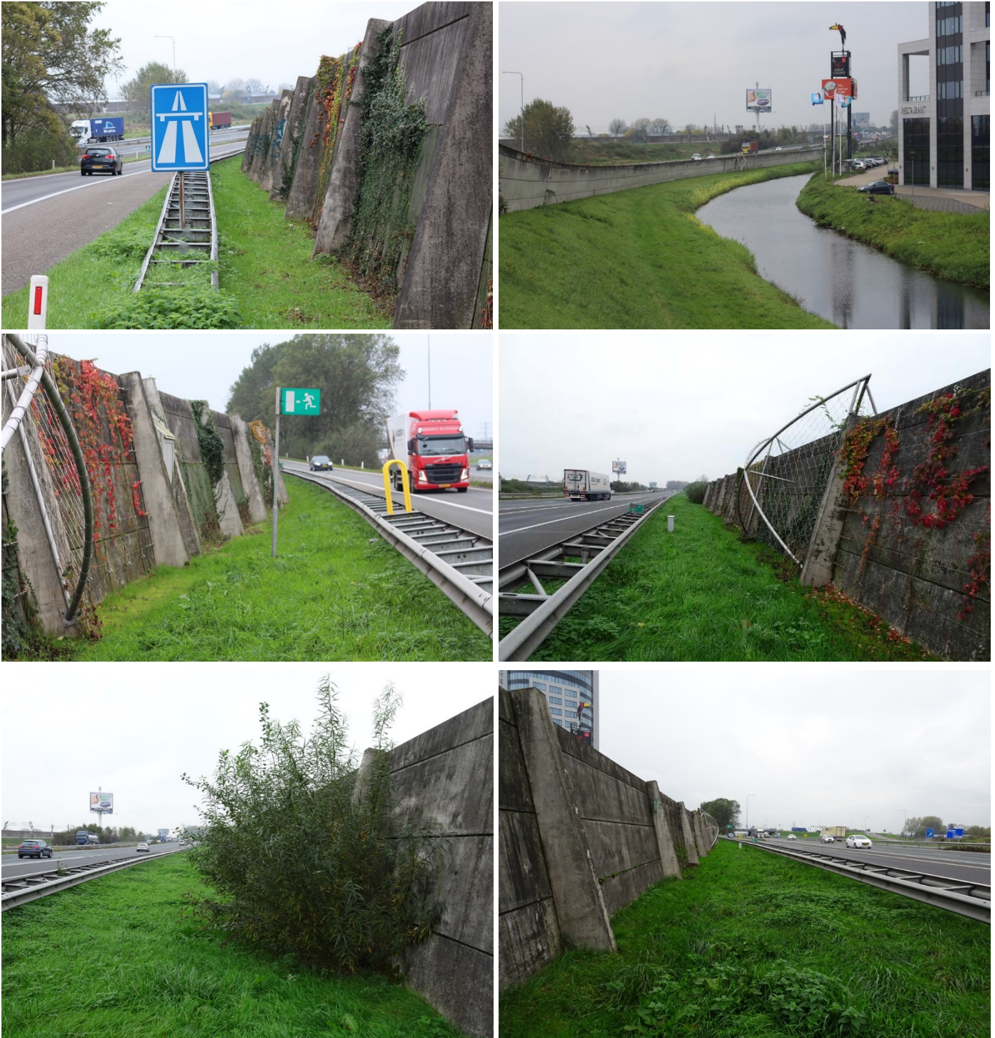
Figuur 3. Modulair geluidsscherm 1 is opgebouwd uit betondelen waar door Rijkswaterstaat wordt geëxperimenteerd met verschillende soorten klimplanten om de geluidswal te vergroenen. Bij het beplanten van de een geluidswal houdt Rijkswaterstaat rekening met het type klimplanten. De groeiwijze, plaats en het (micro)klimaat is bepalend voor het vergroenen van de geluidswal. Bij het vergroenen kunnen zelf hechtende klimplanten, slinger- en rankplanten, steunplanten en/of leiplanten worden gebruikt. In de huidige situatie staan de klimplanten tegen de betonwand op een bed van kiezels met daaroverheen een laag aarde. Door het kiezelbed wordt, vooral tijdens warme zomers, het water te snel afgevoerd. Voor de meeste klimplanten, die van origine toch vooral in bossen en bosranden voorkomen en dus relatief veel schaduw en vocht gewend zijn, kan dit desastreus zijn. Door watertekort kunnen planten minder goed en snel groeien of zelfs afsterven, waardoor het gewenste effect uitblijft. Momenteel wordt er geëxperimenteerd met kunstmatige waterzakken (zie figuur 5: de bruine plastic zak op de foto
