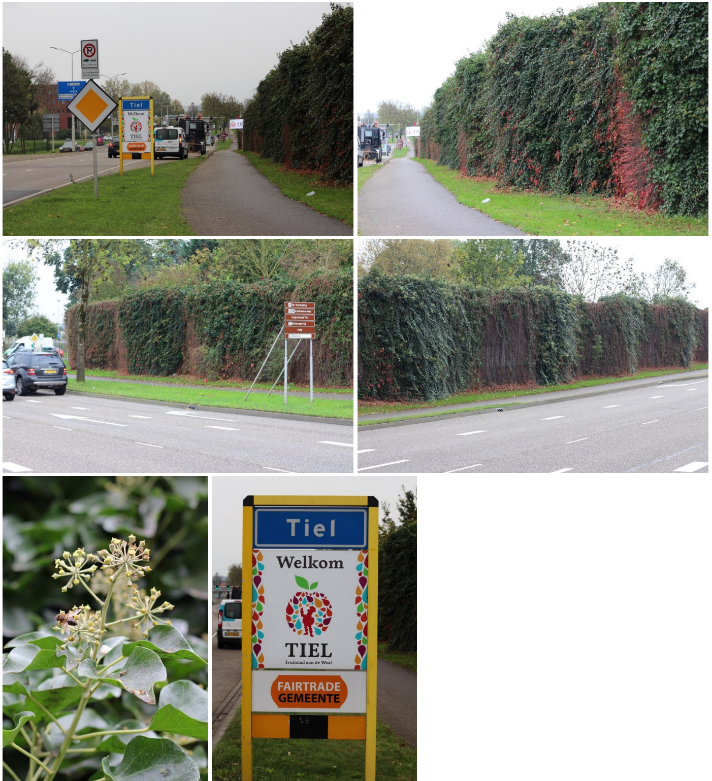
Figuur 10. Geluidsscherf 3, de zogeheten slangenmuur bij binnenkomst van Tiel vanaf de A15. Door de slingerende S-vorm ontstaat er meer variatie en structuur in het geluidsscherf en wordt er op korte afstand van elkaar aan weerszijden een verschillend microklimaat gecreëerd.
